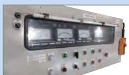
試運転測定器
